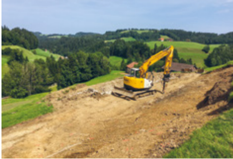
Kugelfang Au – gegen Ende der Sanierungsarbeiten
