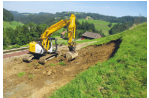
Kugelfang Au – Beginn der Aushubarbeiten hinter dem Scheibenstand
